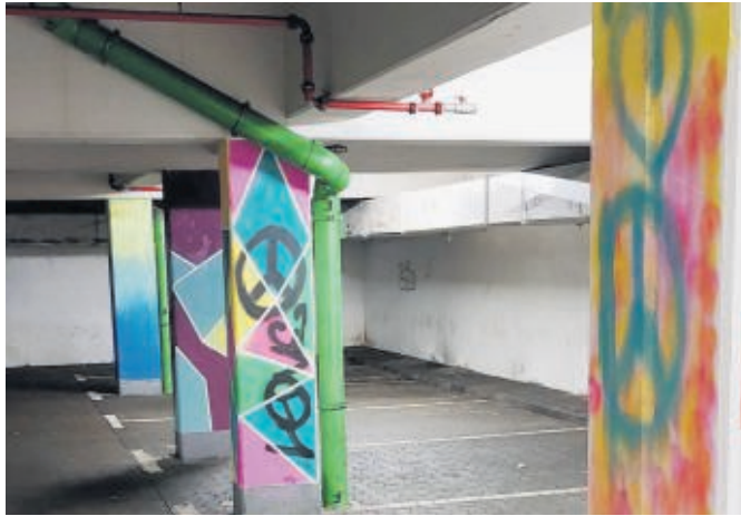
Die vormals eher triste Tiefgarage ist jetzt bunt geworden.
