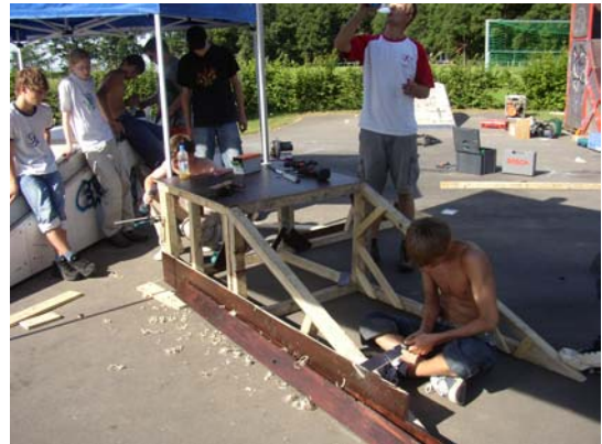
Das Grundgerüst für die Skaterampe steht.
