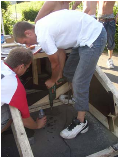
Verankerung der Rampe am Boden.
