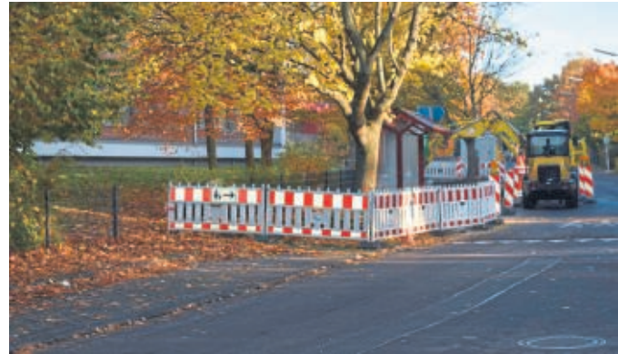
Die Bauarbeiten an der Haltestelle der FES laufen.
