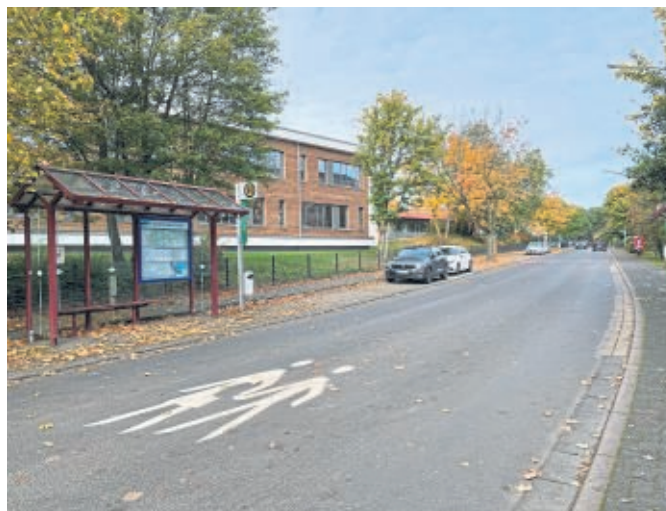
Die Bauarbeiten im Bereich der FES beginnen am Montag.
