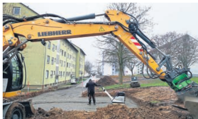
Die Baufirma legt den Untergrund für den kleinen Platz an der Obstwiese an.
