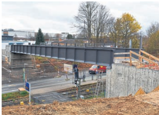
Der Brückenneubau soll im Dezember abgeschlossen werden.
