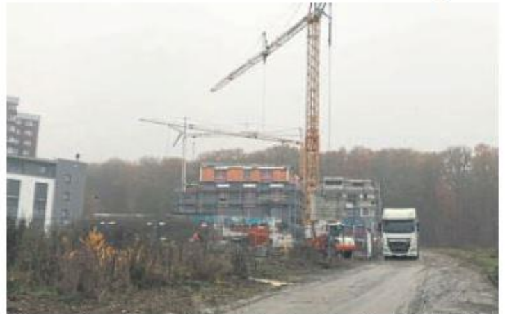
Mehrere Investoren haben mit dem Bau ihrer Mehrfamilienhäuser im Baugebiet Akazienallee begonnen.
