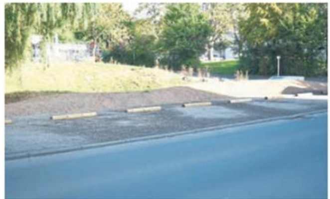
In Höhe des Rückhaltebeckens wurden acht Elternstellplätze eingerichtet.
