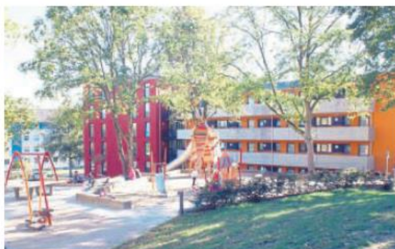
Wohnumfeldmaßnahme der GWH am Neubau Birkenallee 37.
