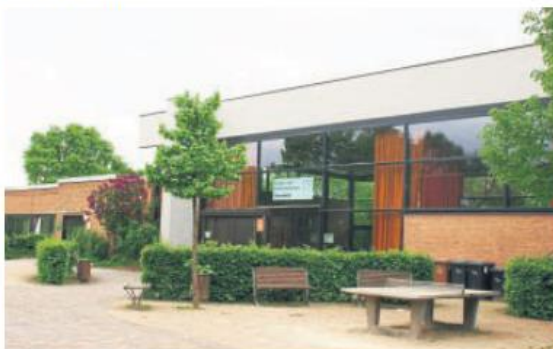
Das sanierte und umgebaute Kinder- und Familienzentrum Baunsberg wurde im Jahr 2017 eingeweiht.
