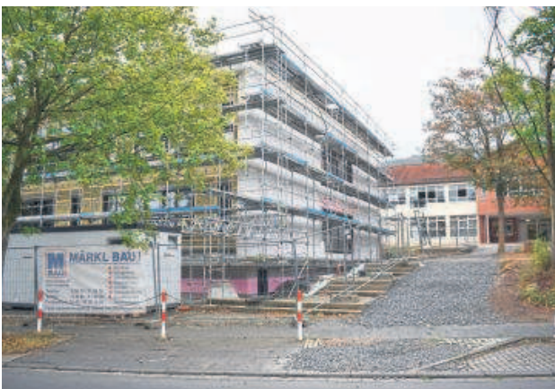
Der Rohbau an der Friedrich-Ebert-Schule steht.
