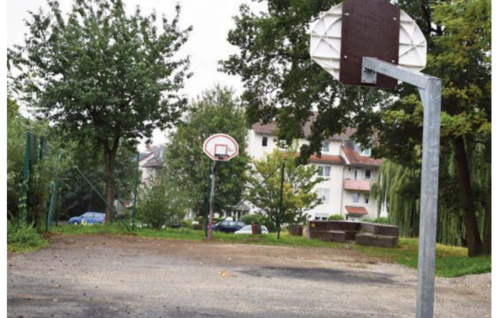
Auch der unterhalb gelegene Basketballplatz ist sanierungsbedürftig, die Arbeiten beginnen voraussichtlich im Herbst.
