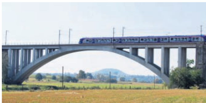
Die Eisenbahnbrücke ist das „Wahrzeichen“ von Guntershausen. Der Stadtteil hatte 2022 den Regional-Ausscheid gewonnen.
