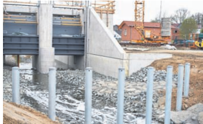
Hochwasserrückhaltebecken in Kirchbauna.
