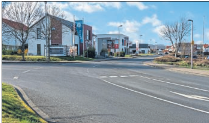
Rostocker Straße: Unübersichtliche Einmündung, schlechte fußläufige Zuwegung zum Edeka-Markt.
