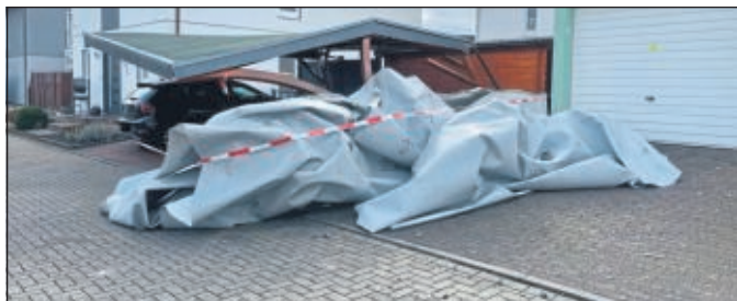
Das vom Sturm abgetragene Flachdach beschädigte unter anderem ein Carport
