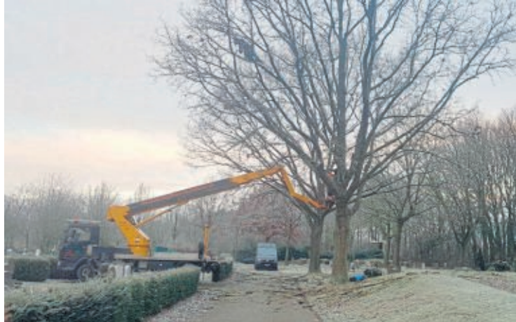
Auf dem Hauptfriedhof in Altenbauna waren die Baumkletterer im Einsatz. Aus 75 Eichen entfernten sie Totholz.
