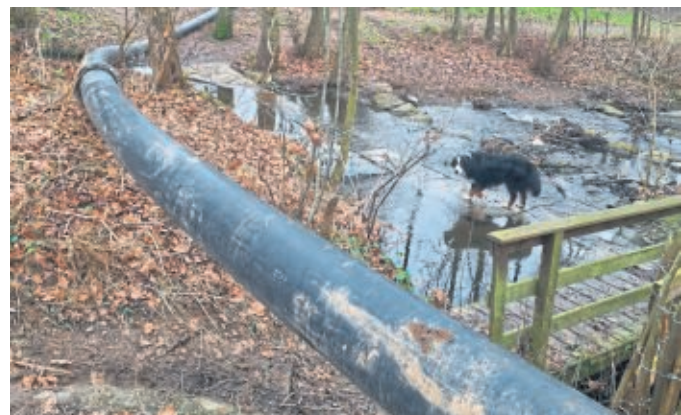
Der Kanal am Fischbach und Mühlenweg wird im Schlauchlining-Verfahren saniert.
