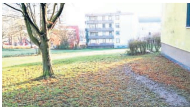
Im Bereich der Obstwiese beginnen die Bauarbeiten für einen neuen barrierearmen Verbindungsweg.
