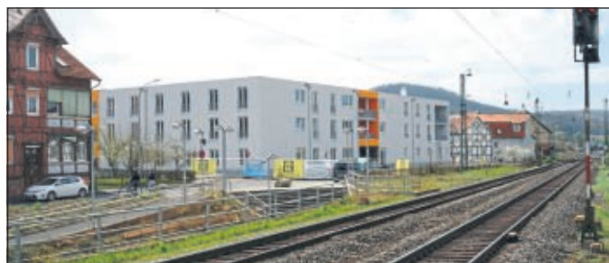
Blick vom Bahnhof Gensungen auf das neue, große Seniorenzentrum. Der Weg dahin führt über Rampen und eine barrierefreie Unterführung.
