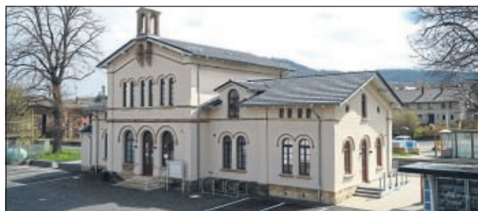
Der historische Bahnhof Felsberg-Gensungen, heute ein Kulturzentrum im Stadtteil Gensungen.
