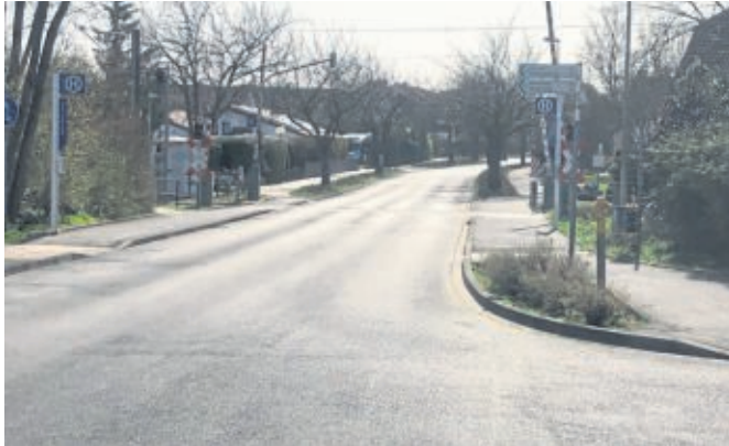
Am Bahnübergang Albert-Einstein-Straße wird der Gleiskörper komplett ausgetauscht.
