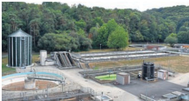
Die Verbands-Kläranlage in Kirchbauna.
