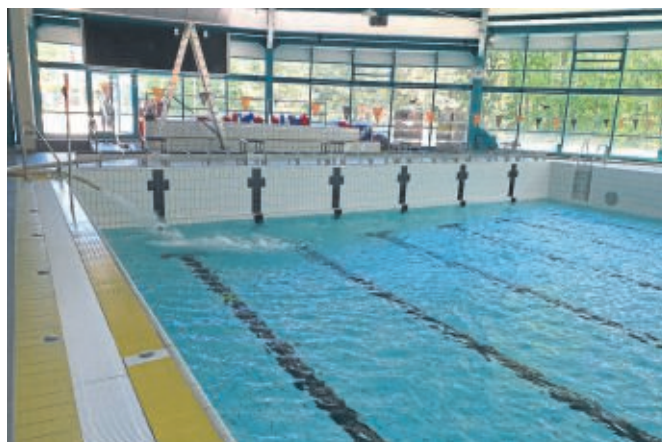
Die Schwimmbecken im Baunataler Sportbad werden über mehrere Tage mit Wasser befüllt.
